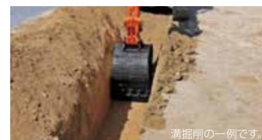
溝掘削の一例です。
